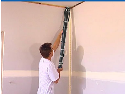
Applicazione carta e stucco Plastermix su angolo interno*
