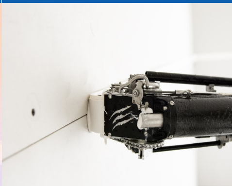
Applicazione carta e stucco Plastermix su giunto a parete °
