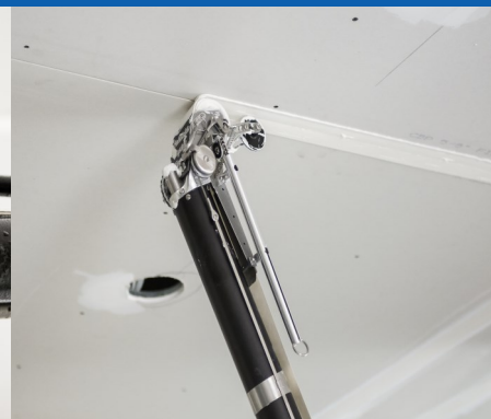
Applicazione carta e stucco Plastermix su giunto a soffitto °
